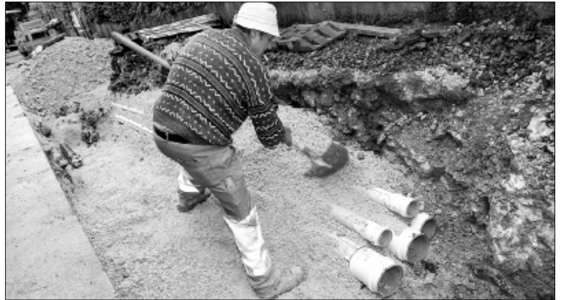
Les responsables d'EDJ Energie du Jura savent que l'accroissement des ventes de gaz passe par l'extension de leur réseau de distribution. Comme c'est actuellement le cas à la rue des Martins, à Delémont.
